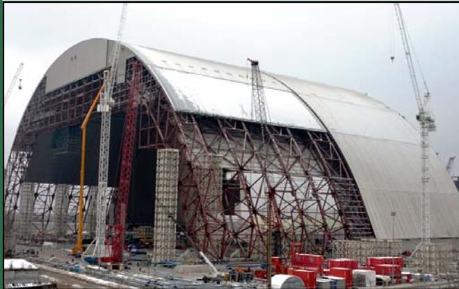
перемещению Восточной части Арки нового безопасного конфайнмента в зону ожидания. Параллельно с деятельностью по монтажу Арки велись работы по устройству фундаментной плиты технологического здания и здания электротехнических устройств:
