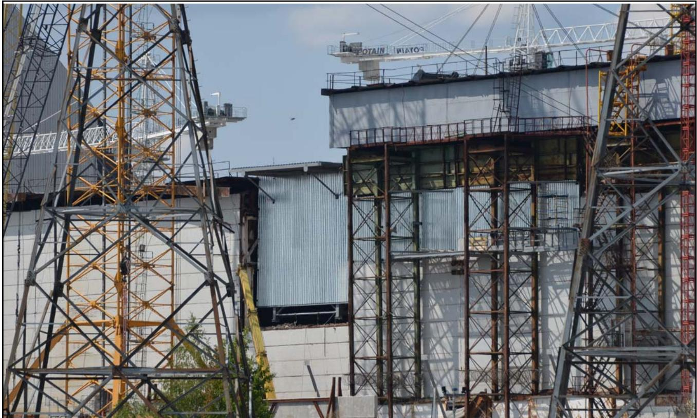
25 декабря подписан Акт о готовности объекта к эксплуатации в рамках проекта "Восстановление ограждающего контура машинного зала 4-го энергоблока ЧАЭС между осями 46-52 и А-Б". В аварийный проем, образовавшийся в результате обрушения
