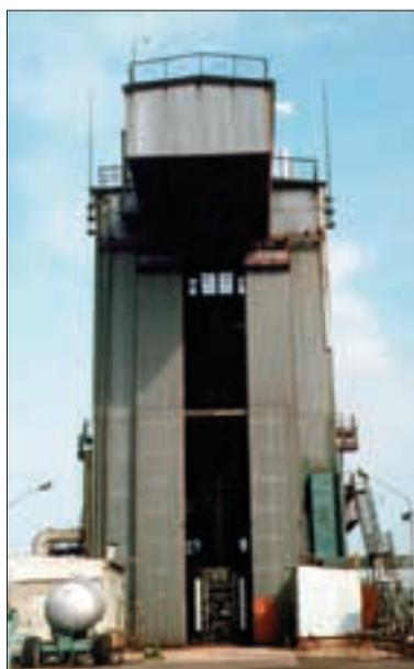
**НИИХИММАШ** – головной испытательный центр Федерального космического агентства по стендовой отработке жидкостных ракетных двигателей, двигательных установок на различных компонентах топлива, а также по испытаниям космических аппаратов в термобарокамерах в условиях имитации космоса.
